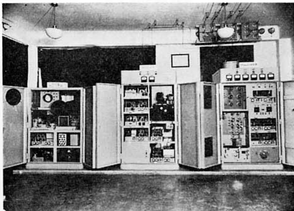
自動記録式電離層観測装置 (6 型) 観測自動記録部
