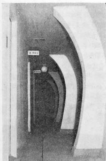
標準電波地下原器室の一部 (廊下)
