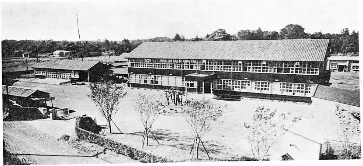
電波研究所小金井庁舎本館 (昭和 27 年)
