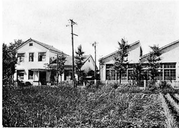
茨窪庁舎玄関 (向って左) (昭和 27 年)
