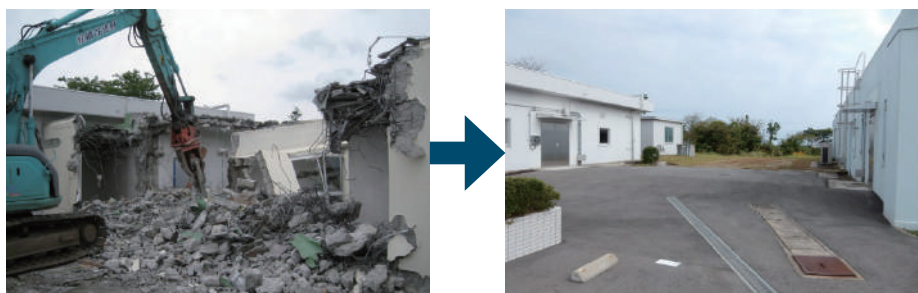
(↑写真左は復旧困難となり撤去することになった工作棟などの撤去工事の様子、右は撤去後)
