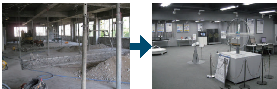
(↑写真左は被害を受けた展示館内部の復旧工事の様子、右は復旧後)
