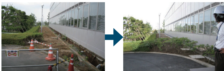
(↑写真左は震災で80cm沈んだ地面、建物下の茶色い部分が基礎、右は復旧後)
