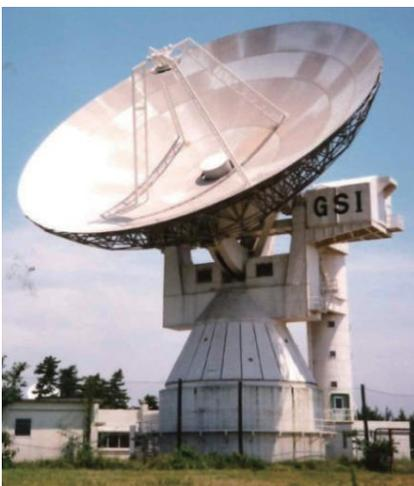
図3 国土地理院に移管された26mアンテナ（GSIのロゴ）下にVLBI庁舎が建設された
