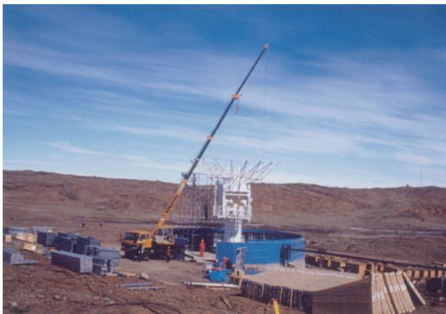
写真(1) 南極 11m アンテナの組み立て
