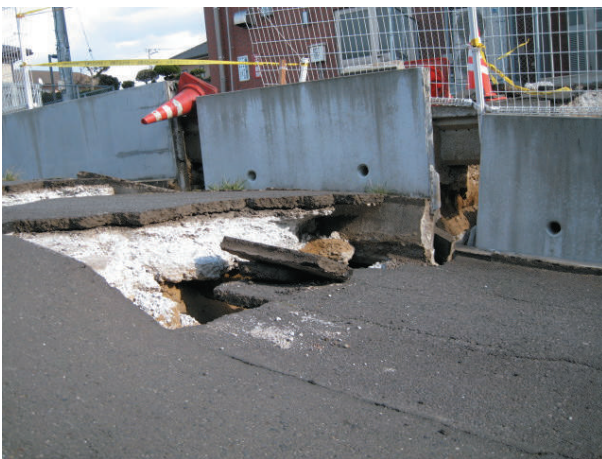
鹿島宇宙技術センター近辺道路被害その4 (34m アンテナから約 500 メートル程の場所)
