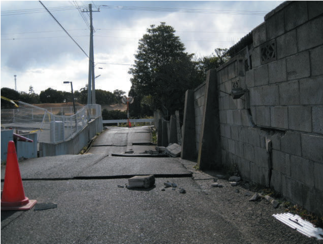
鹿島宇宙技術センター 近辺道路被害その1 (34m アンテナから約 300メートル程の場 所)
