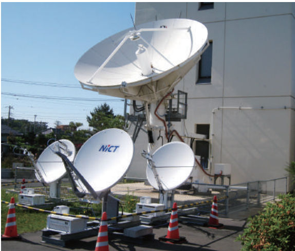
WINDS 用 4.8m 地上局アンテナ 2010年撮影 高速・大容量のインターネット衛星通信実験など様々な実験をおこなっている。
