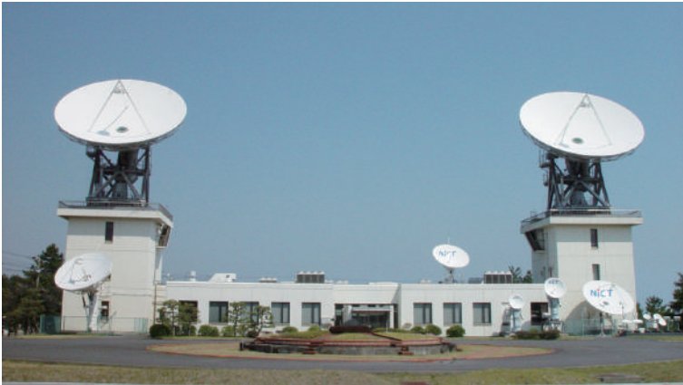
衛星通信実験棟（13m アンテナなど） 1975年～2015年 BS放送やCS衛星通信のための実用化実験等をおこなった。
