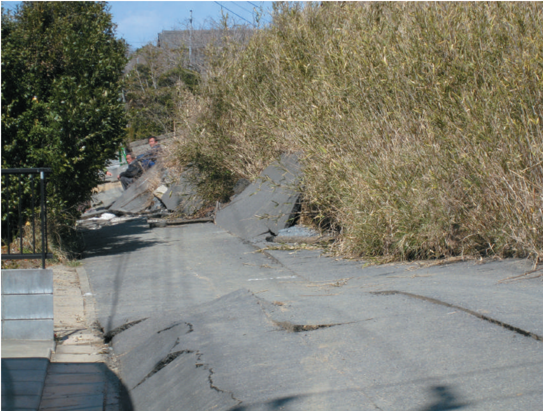
鹿島宇宙技術センター 近辺道路被害その3 (34m アンテナから約 500メートル程の場所)
