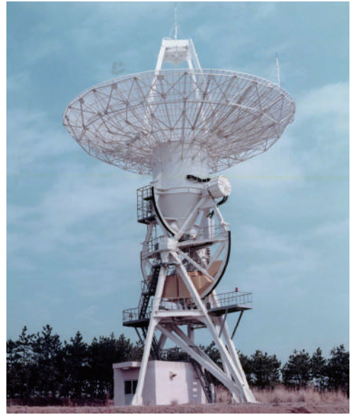
18m アンテナ 1971年～1987年 日本初の電離層観測衛星「ISS(うめ)」受信用アンテナとして新設された。通常見られるようなAZ(方位角)／EL(仰角)タイプのアンテナと異なり、高い仰角追尾(移動衛星)に有利なX／Yマウントタイプのアンテナ。
