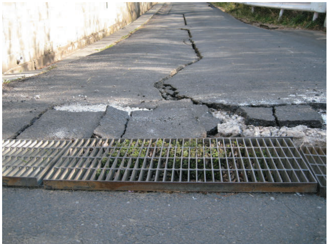
鹿島宇宙技術センター 近辺道路被害その2 (34m アンテナから約 300メートル程の場 所)
