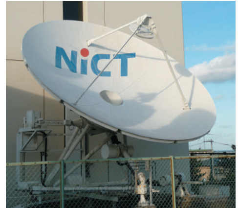
ETS-III 用 5m 地上局アンテナ 2010年撮影 災害などを早期に発見する衛星通信実験など様々な実験をおこなった。
