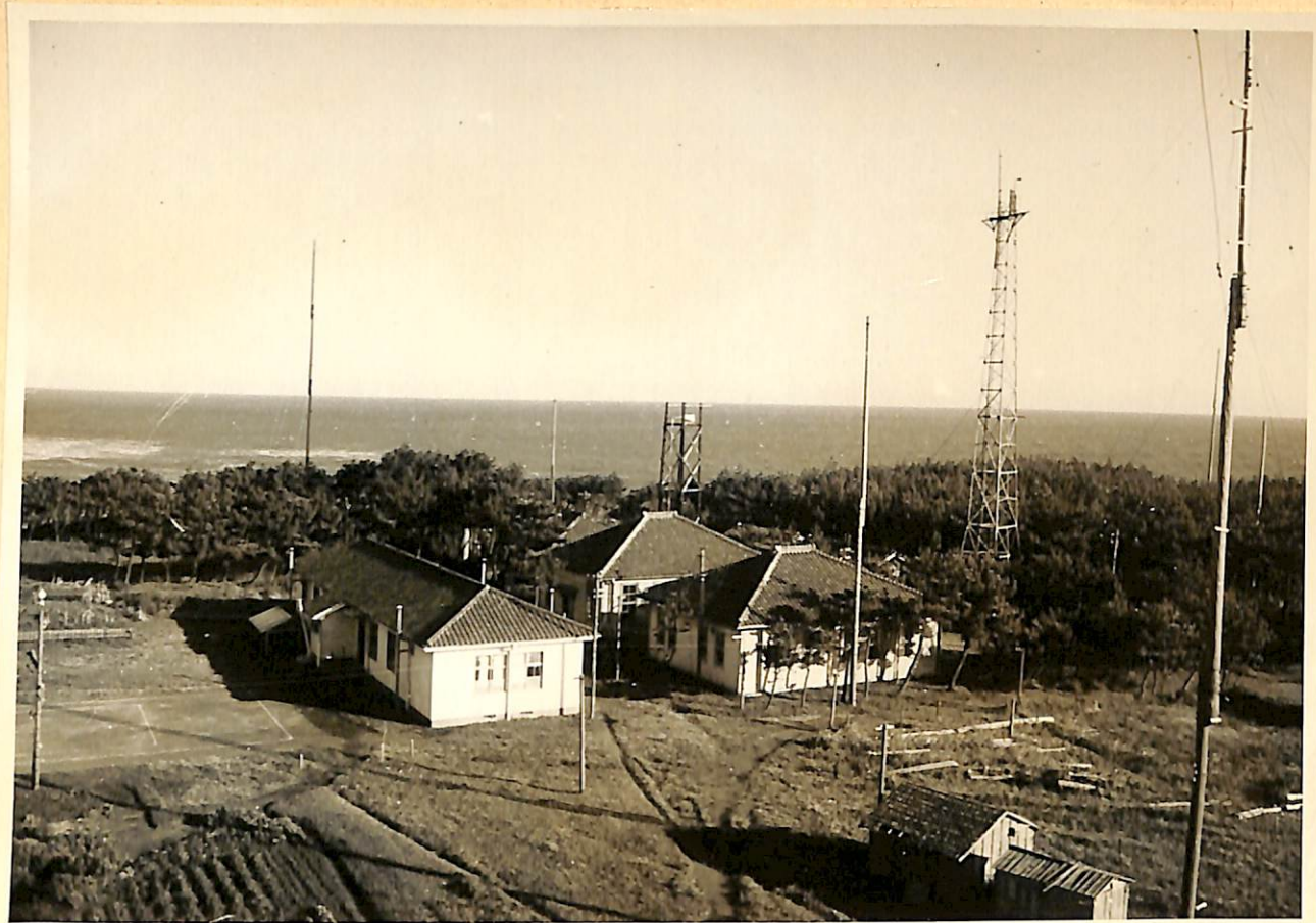
平磯電波観測所舎
